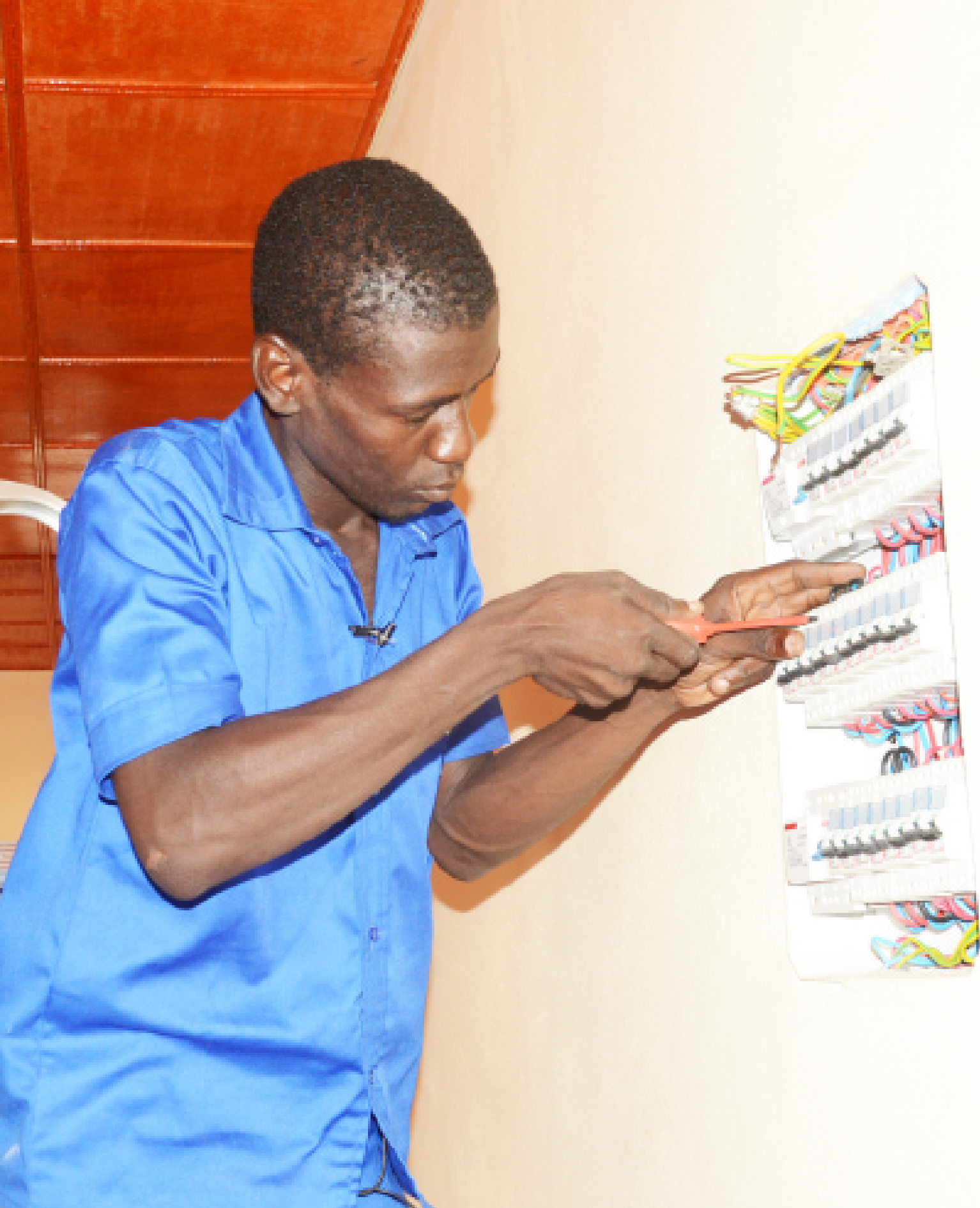
Mahaman Laouati, un jeune formé en électricité bâtiment par le PRODEC via le FAFPA - Zinder 2018
